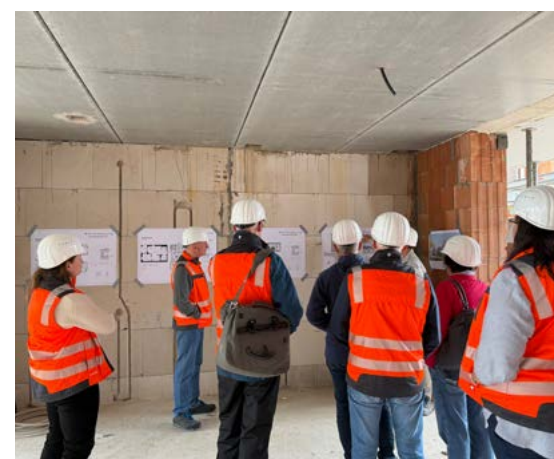
Mitglieder des Bauausschusses vom Aufsichtsrat verschaffen sich auf der Baustelle am Marktplatz einen Überblick.
