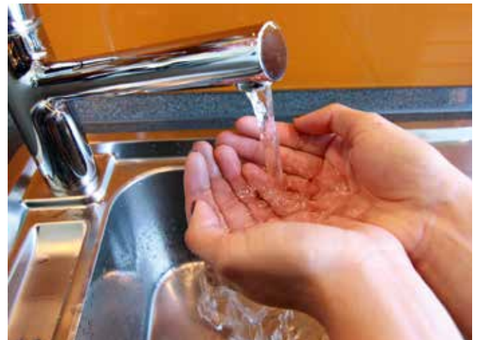
Ein hohes Gut: sauberes Trinkwasser durch saubere Wasserleitungen
