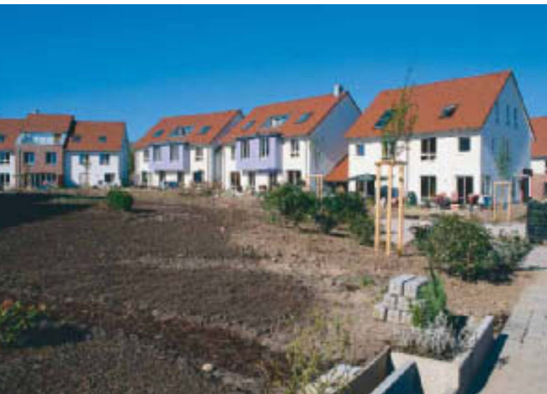
Für Schallschutz nach DIN 4109 ist an der Gottlieb-Binder-Straße gesorgt.
