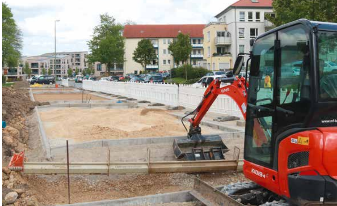
Mit der Fertigstellung der Parkbuchten wird in diesem Jahr der Stadtumbau Albert-Schweitzer-Straße abgeschlossen.
